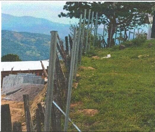
Foto 3: Mejoramiento de cercamiento perimetral
