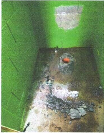
Foto1: Mejoramiento de servicios sanitarios
